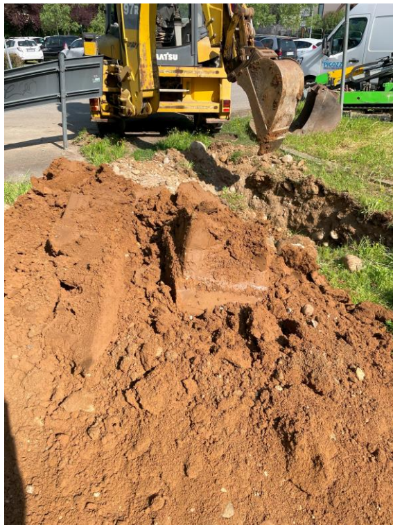
Vista stazioni prove penetrometriche e scavo esplorativo
